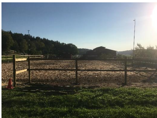
Upprustning av utevolten pågår
